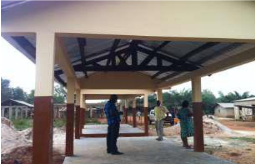
Photo n°1 : Travaux d'extension du marché de Ouèdèmè
