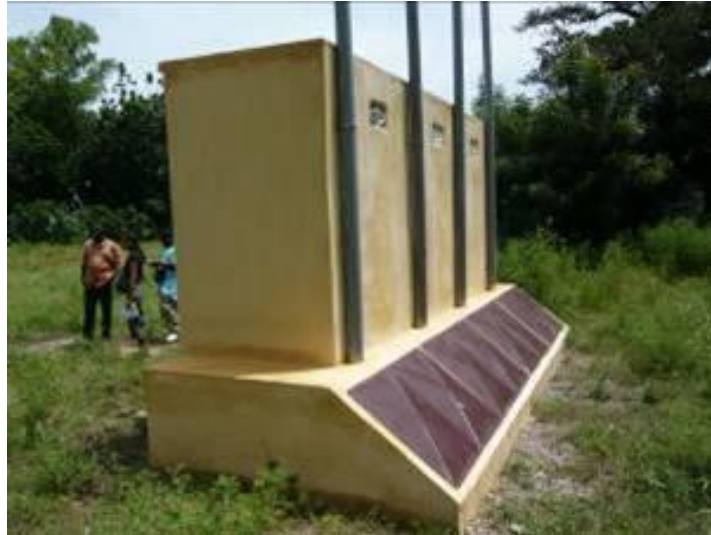
Photo n°4 : vue de face extérieure d'une cabine ECOSAN
