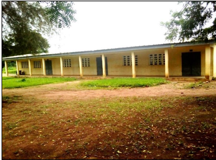
Photo 2 : École primaire d'Attien-Kouassikro réhabilité par le conseil municipal
