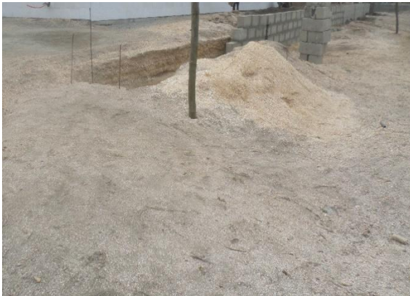
Figure 6 : Complexe hôtelier bâti sur le site 3 Kass
